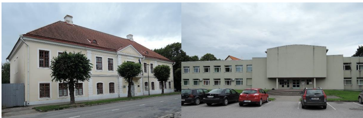
Tallinna tn 18 fassaad ja külgvaade
